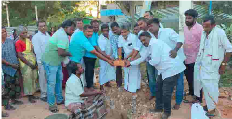
தூத்துக்குடி ஊராட்சி ஒன்றியம், ஒட்டபிடாரம் சட்டமன்றத் தொகுதிக்குட்பட்ட அய்யனடைப்பு கிராமத்தில் ரூ.15.50 லட்சம் மதிப்பீட்டில் புதிய ரேஷன் கடை கட்டுவதற்கான பணிகளை ஒட்டபிடாரம் சட்டமன்ற உறுப்பினர் எம்.சி.சண்முகையா நேற்று அடிக்கல் நாட்டுவதற்கான அடிக்கல் நாட்டுகிறார். சேதமடைந்து கிடக்கும் அய்யனடைப்பு ஊராட்சி மன்ற அலுவலகத்தை தரையில் கட்டி எம்.சி.சண்முகையா எம்.எல்.ஏ. பொதுமக்களின் கோரிக்கையை ஏற்று, அக்கட்டிடத்தை மக்கள் பயன்பெறும் வகையில் புதிய திட்டங்களின்படி, கட்டி தருவதாக உறுதி கூறினார். முன்னதாக, எம்.எல்.ஏ.வுக்கு இளைஞரணி, ஊர்மக்கள் சார்பில் சிறப்பான வரவேற்பு அளிக்கப்பட்டது. இந்நிகழ்ச்சியில், தூத்துக்குடி ஊராட்சி ஒன்றிய உதவி பொறியாளர் ரவி, வருவாய் ஆய்வாளர் மேகலா, தூத்துக்குடி மத்திய ஒன்றிய திமுக துணை செயலாளர் ஹரி பாலகிருஷ்ணன், இலக்கிய புகழ்நிலை பேரவை தலைவர் சத்யபாண்டிராஜ் உள்ளிட்ட நிர்வாகிகள் மற்றும் ஊர் பொதுமக்கள் பலர் கலந்து கொண்டனர்.
